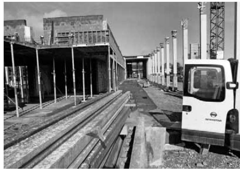
Noch nicht fertiggestellt ist die neue Mehrzweckhalle in Aitrach. Vor der Nutzung der Mehrzweckhalle und der Sporthalle hat nun der Gemeinderat eine neue Benutzungs- und Entgeltordnung beschlossen, die ab dem 1. November in Kraft tritt. FOTO: OLAF SCHULZE
